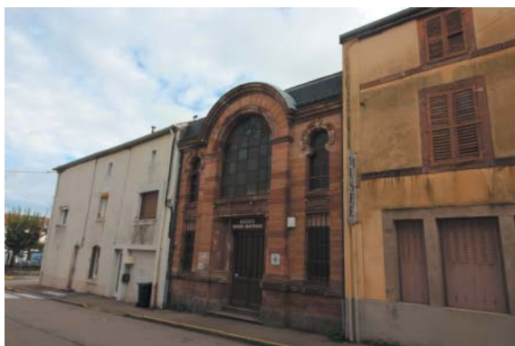
Naruzovělá synagoga v městečku Bruyères. Foto autor.
