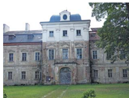
Zámek dolní Lukavice, vstupní průčelí.
