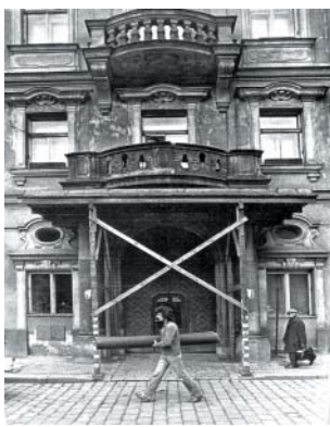
Portál Kafkova rodného domu začátkem 80. let. Foto Jiří Gruša.
