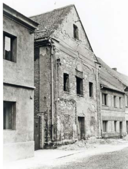
Osekané průčelí synagogy. Foto J. Fiedler 1979.
