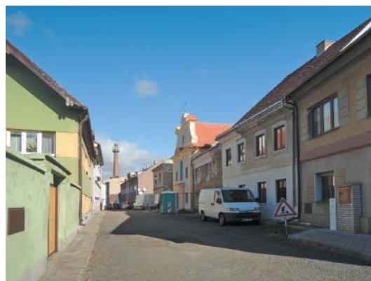
Pohled do Ostrovni, dříve Židovské ulice s opravenou synagogou.
