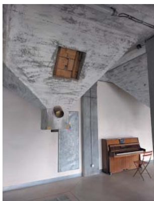
Jeden z opravených betonových trychtýřů.
